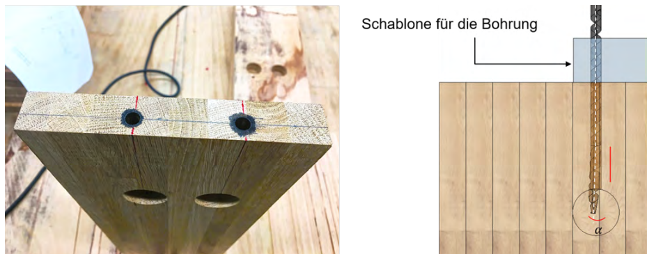
Abbildung 4.15: Abweichung der Bohrung & Erhöhung der lokalen Temperatur beim Bohren
