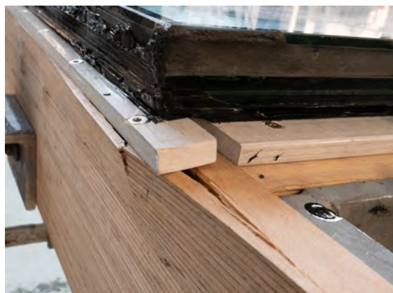
Abbildung 8.35: Großprüfkörper 2.2 / Riss Druckpfosten nach Wiederbelastung
